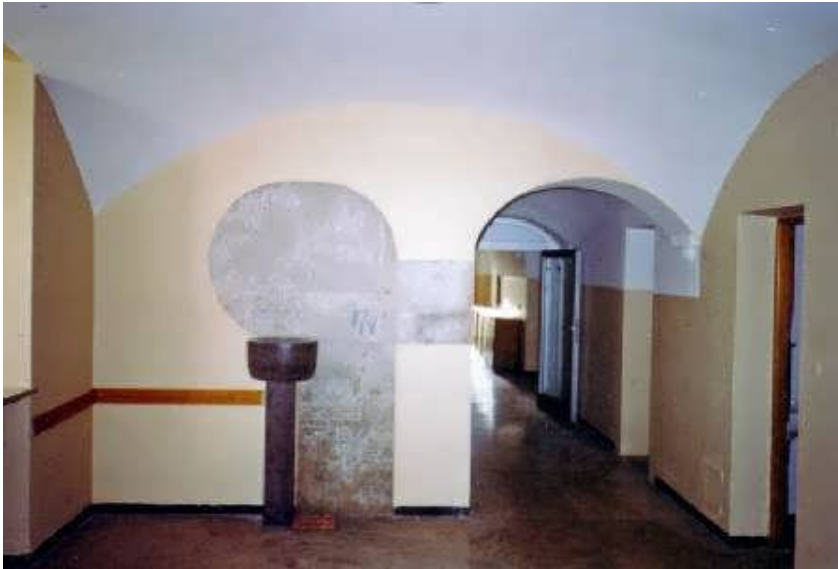
Erdgeschoss im Wirtschaftsgebäude
